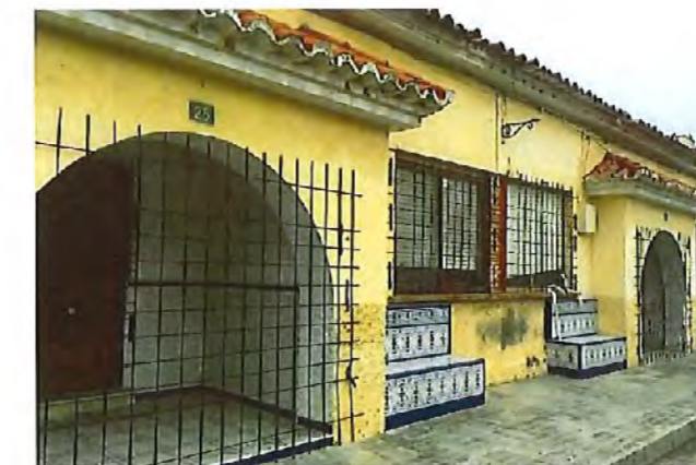
Figura 18. Detalle de los accesos cerrados a dos viviendas del barrio Heliodoro Madrona.
