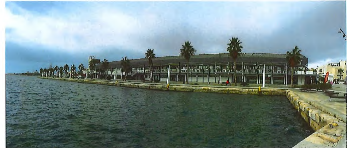
Figura 21. Vista general desde el Sureste del muelle 10.
