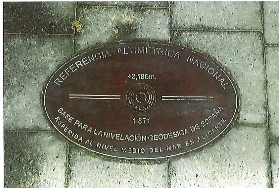
Figura 31. Detalle de la placa de bronce que aparece insertada en el suelo frente al acceso al mareógrafo Alicante 2.
