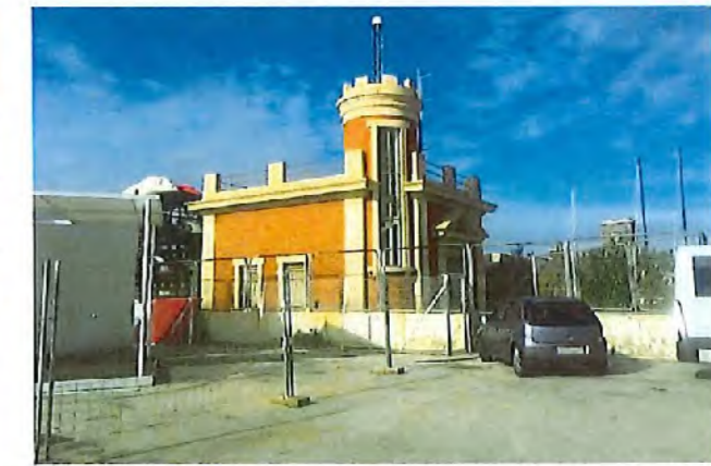
Figura 23. Vista desde el Noreste del mareógrafo Alicante 1.
