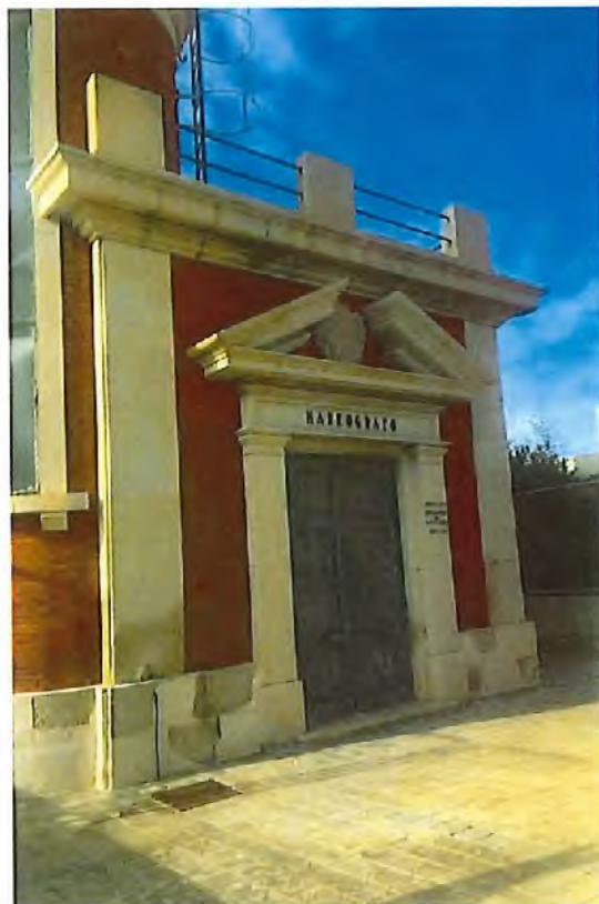
Figura 24. Detalle de la fachada principal del mareógrafo Alicante 1.
