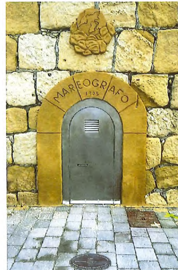
Figura 29. Detalle del acceso al mareógrafo Alicante 2.
